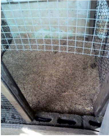
Figura 1. Construcción de las Jaulas
